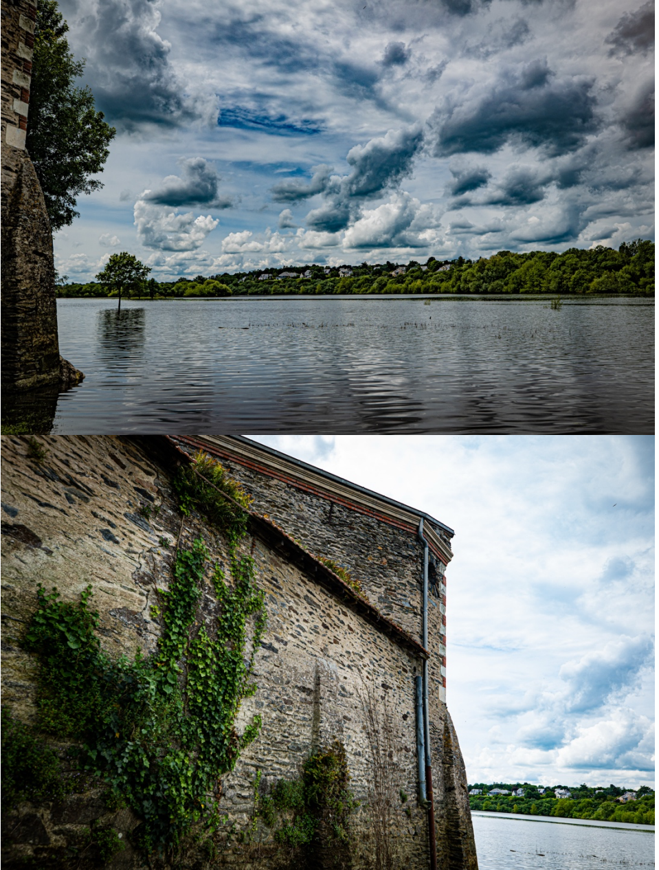
La Baumette route d'eau
